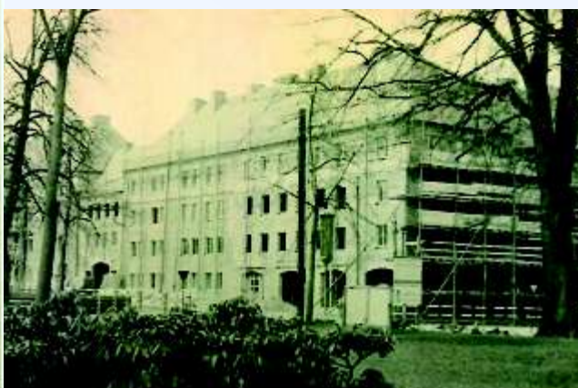
1959 - Wohnung im Bau
