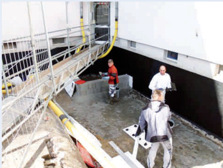
Die Fundamente werden vorbereitet
