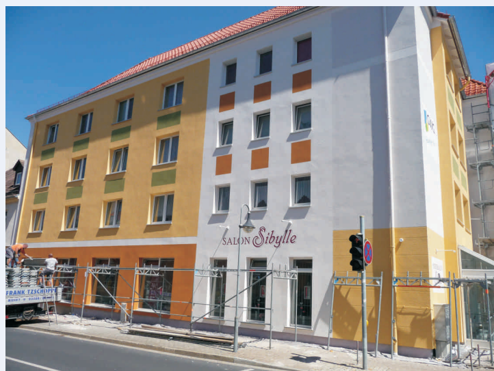
Die Fassade im neuen Glanz
